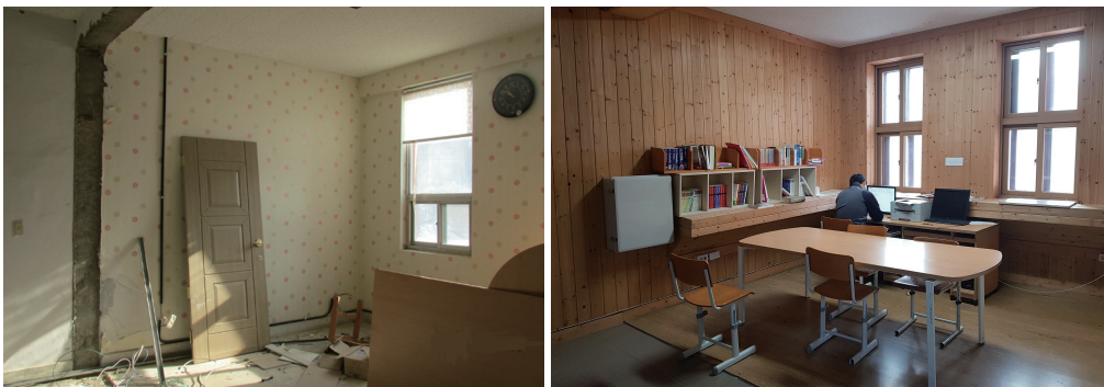
4층 미디어스페이스실 공사 전후
